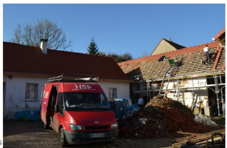
La ferme située rue de Montreuil est en plein travaux.
