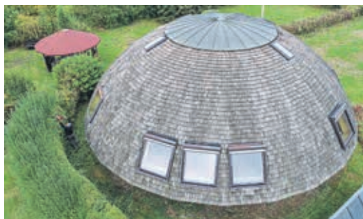
Deux cents maisons Domespace rotatives ont été installées en France.
